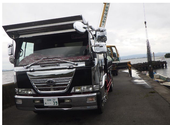
〈表層刈取揚陸運搬作業〉
