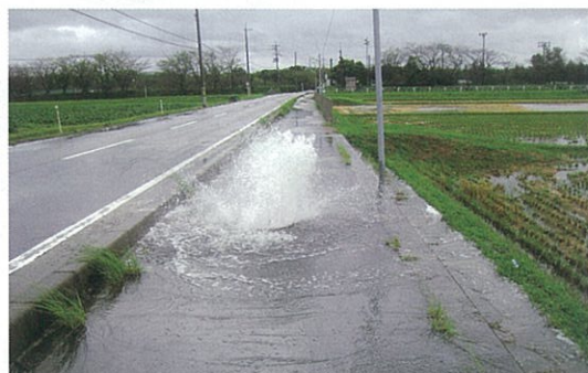
マンホールから汚水があふれ出る様子
