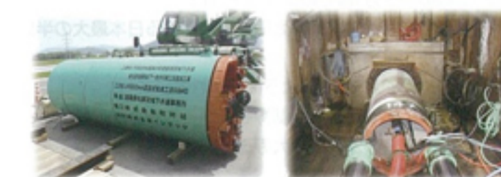
推進工事の現場 (左: 推進機、右: 発進立坑の中)
