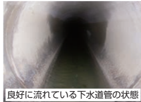
良好に流れている下水道管の状態
