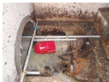
下水道管をクリーニングして出てきたピグの回収状況（金属製の網でキャッチします）
