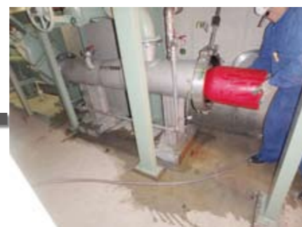
ピグ発射台に装てん作業中の状況
