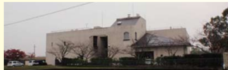
滋賀県守山ポンプ場
