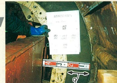
④コンクリートの打ちつけ(二次覆工)
