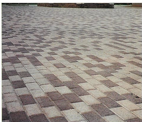
溶融スラグを使ったブロックの使用例(県立水環境科学館)
