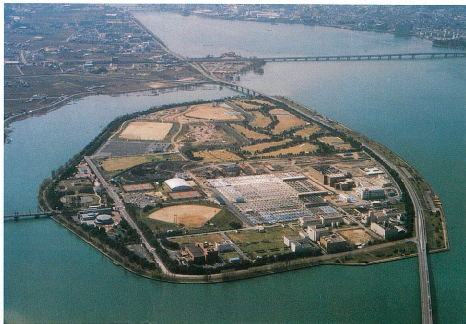
浄化センター
