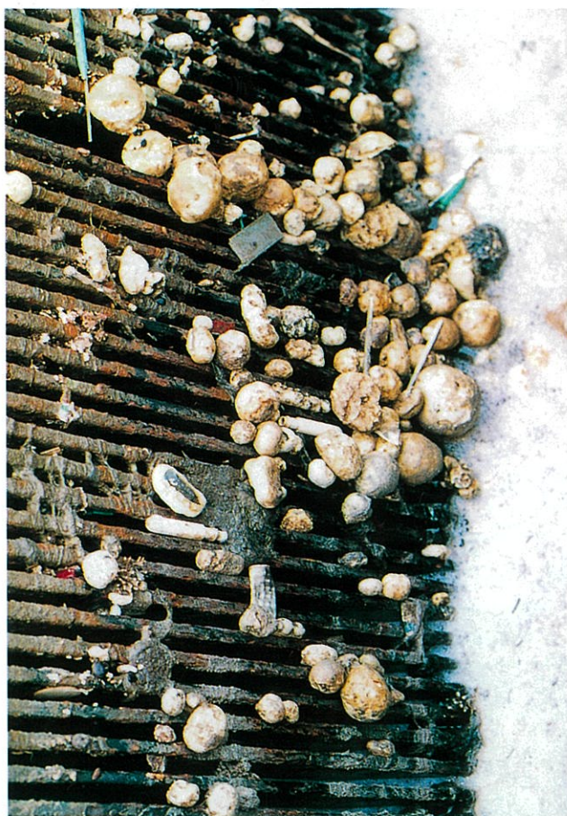
浄化センターに流れ着いた天ぷら油など（ボール状のもの）
