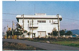
石部ポンプ場 (石部町石部)
