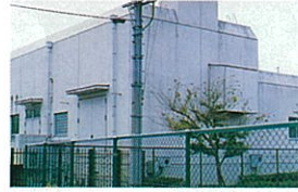
衣川ポンプ場 (大津市衣川)
