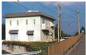
宮井ポンプ場 (蒲生町宮井)
