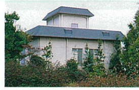
木戸ポンプ場 (志賀町木戸)
