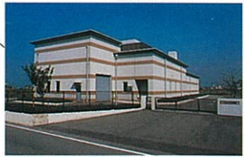
宇曾川ポンプ場 (彦根市須越町)
