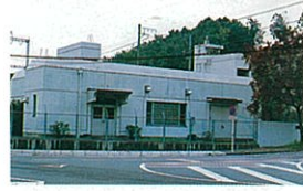
清水ポンプ場 (大津市真野)
