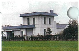
安土ポンプ場 (安土町香庄)
