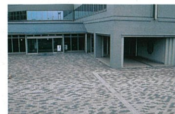
◀スラグを用いたインターロッキングブロック ▼溶融スラグ
