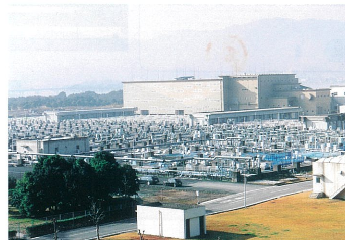
湖南中部浄化センター運転状況(平成10年度)
