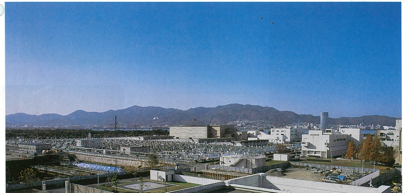
浄化センター
