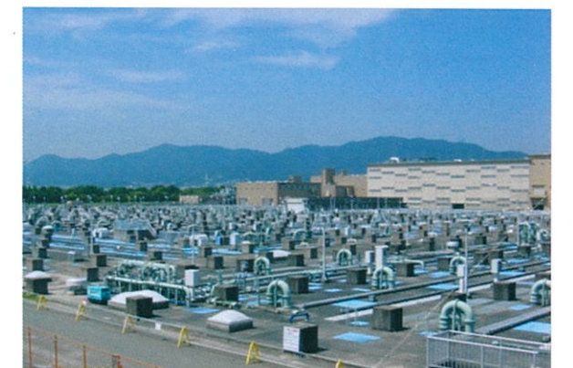
湖南中部浄化センター
