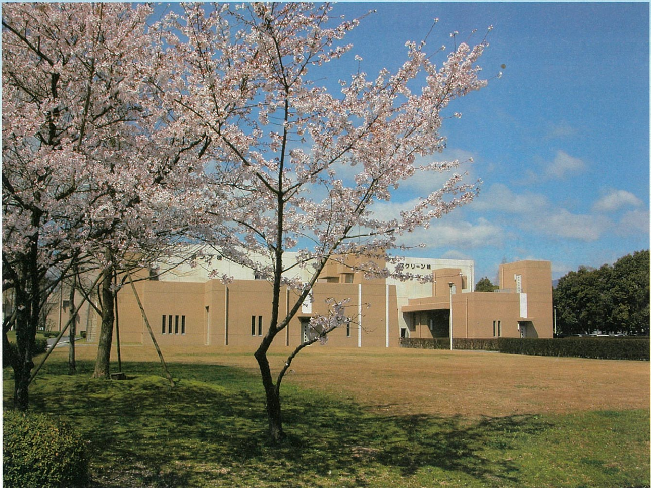
湖南中部浄化センターの春（ポンプ棟・スクリーン棟）
