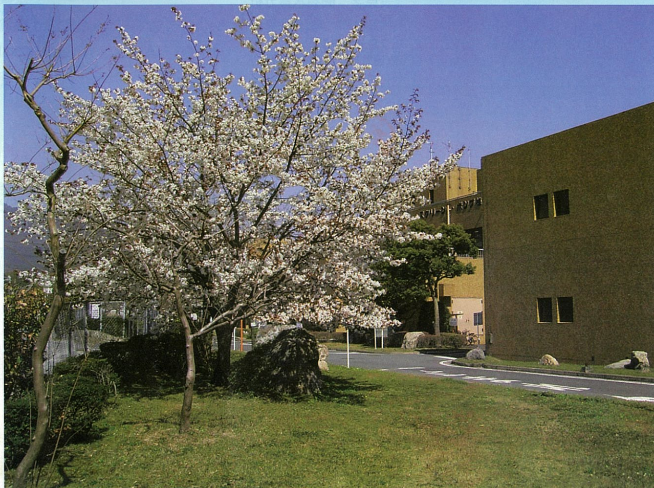
湖西浄化センターの春（電気棟）
