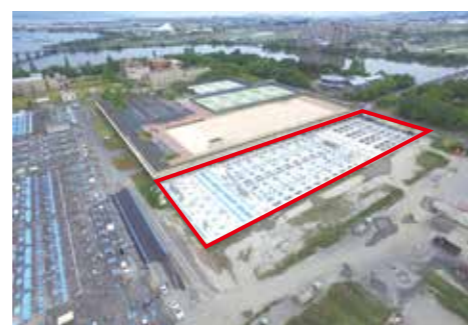
上空からみた水処理施設
