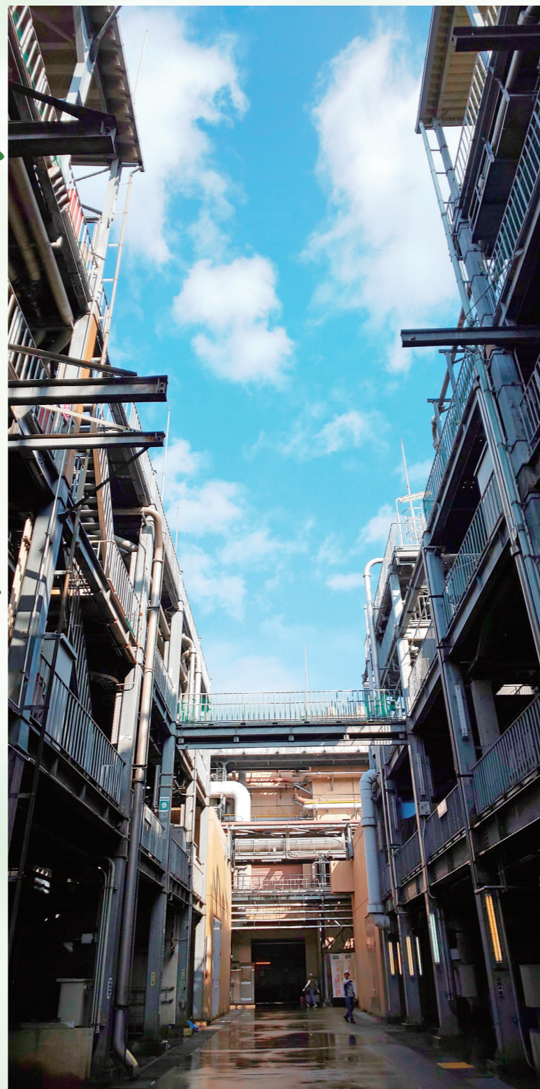
湖南中部浄化センター溶融炉棟
