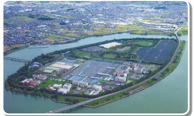
湖南中部浄化センター
