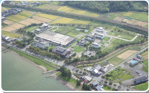
高島浄化センター
