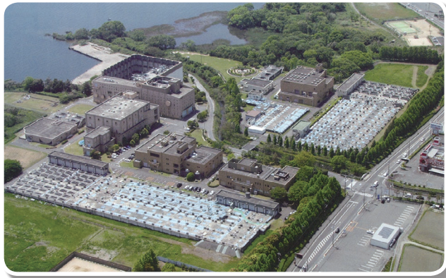
湖西浄化センター
