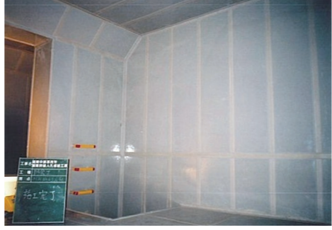
実験を行っているマンホールの内部
