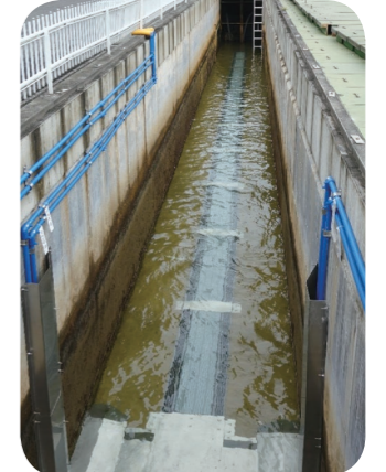
消毒槽への熱回収管敷設状況
