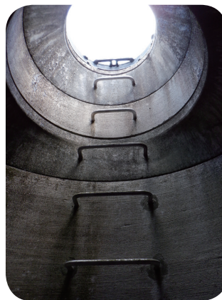
マンホールの内部
