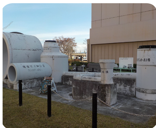
マンホールと下水道管の地中部の展示
