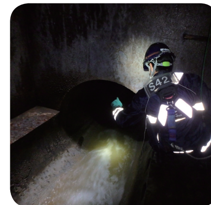
マンホールの内部および下水道管の点検
