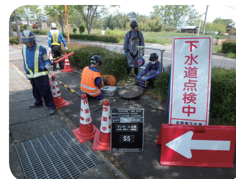
マンホールの地上部の点検
