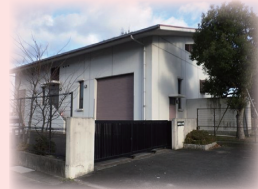
速野ポンプ場
