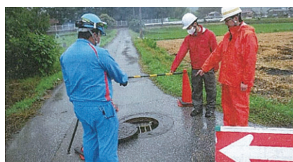
マンホールの点検訓練
