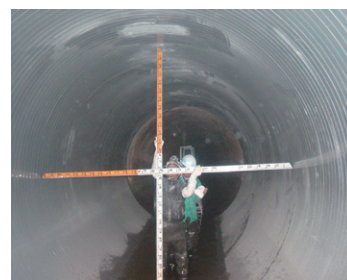
管更生工事の様子
