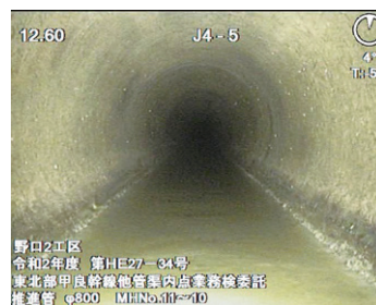
下水管の内部点検
