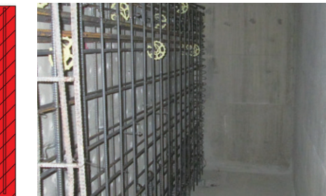
コンクリート壁を分厚くしたりしています
