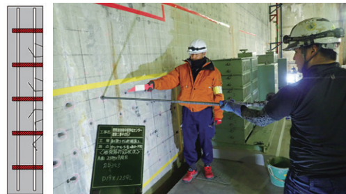
補強の鉄筋を追加したり
