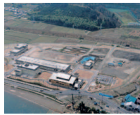
高島浄化センター建設当初
