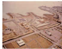
湖西浄化センター建設当初
