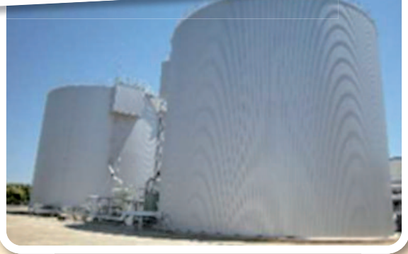
湖南中部浄化センター 下水汚泥のメタン発酵によるバイオガスの生成および有効利用 (※未供用のため、豊橋市の施設を掲載。出典：国交省HP)
