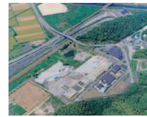
東北部浄化センター建設当初
