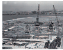
湖南中部浄化センター建設工事
