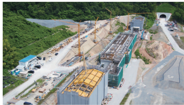
A 系列の建設工事をしています！
