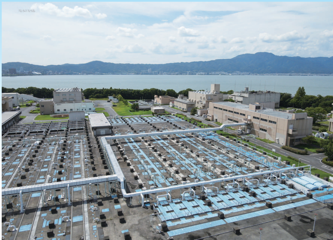
湖南中部浄化センター（草津市矢橋帰帆島内）水処理施設
