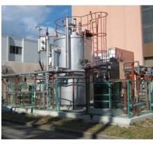
高効率熱可溶化消化装置は、脱水した消化汚泥に高圧蒸気を吹き込み、160~170℃に保たれた可溶化タンク内での水熱反応によって、汚泥中の難分解有機物が改質され、消化しやすい物質となります。その可溶化汚泥を消化槽に返送することによって、有機物の分解率を向上させ、消化汚泥の減容化と消化ガスの増収を図ります。
