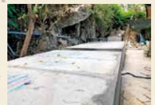
ドーゴー島の浄化槽(工事中)
