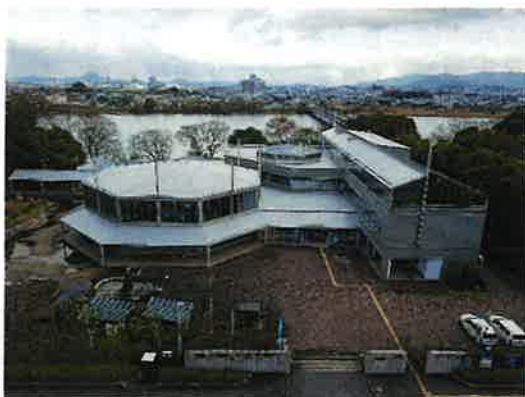
〈外壁工事完了後の淡海環境プラザ(R6.3)〉
