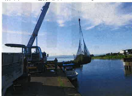
〈表層刈取揚陸運搬作業〉
