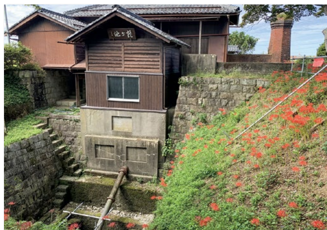
【龍ヶ池揚水機場】
